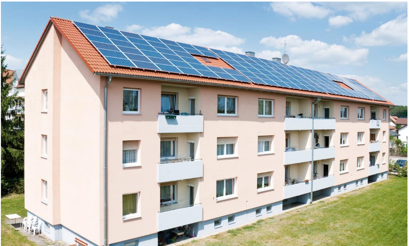
Bild: Anlage am Standort Eichenweg (2011)
