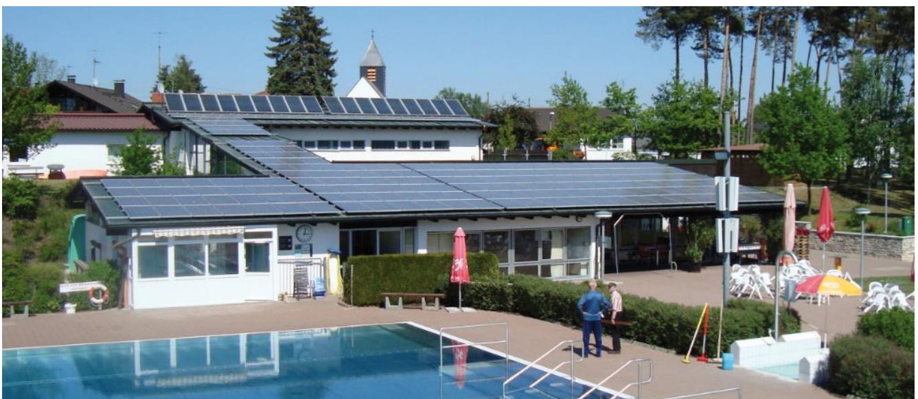
Bild: Anlage am Standort Lärchenweg, Freibad (2011)
