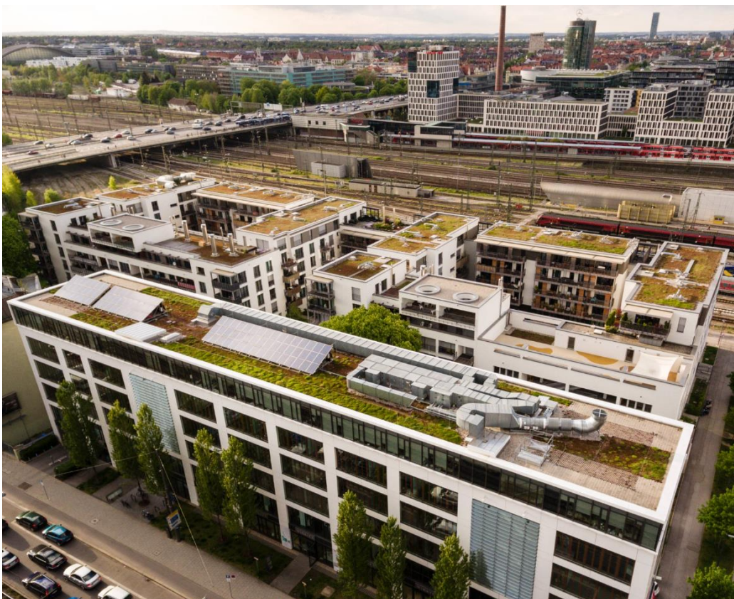
Bild: Anlage am Standort Landsberger Straße 2016
