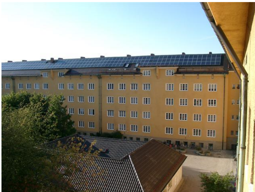
Ansicht PV-Anlage am Standort Zum Künstlerhof
