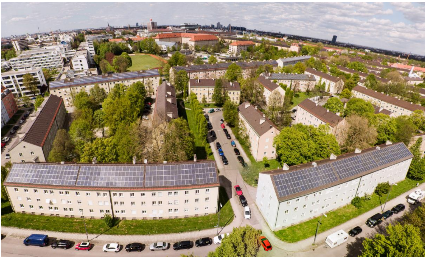
Bild: Anlage am Standort Wilramstraße im Frühjahr 2016.
