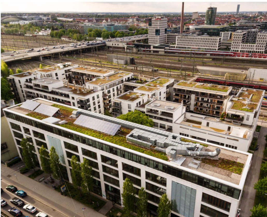
Bild: Anlage am Standort Landsberger Straße 2016
