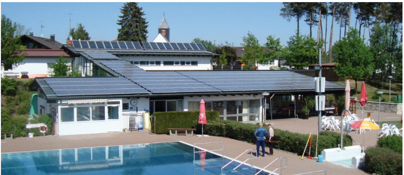
Bild: Anlage am Standort Lärchenweg, Freibad (2011)
