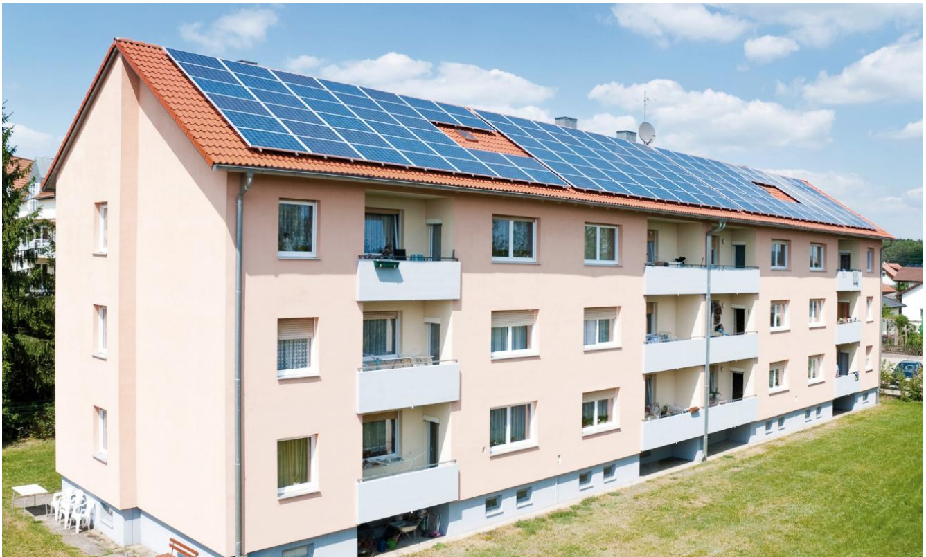
Bild: Anlage am Standort Eichenweg (2011)
