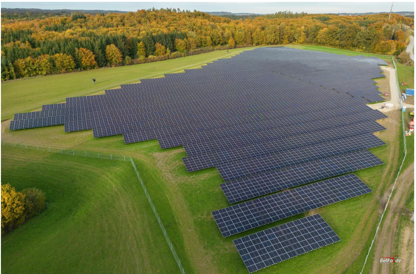
Abgeschlossene Modulmontage aufgenommen am 31. Oktober 2023 | Bild: Firma Belle-Systems
