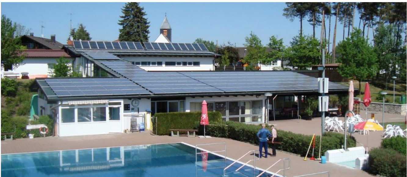
Bild: Anlage am Standort Lärchenweg, Freibad (2011)
