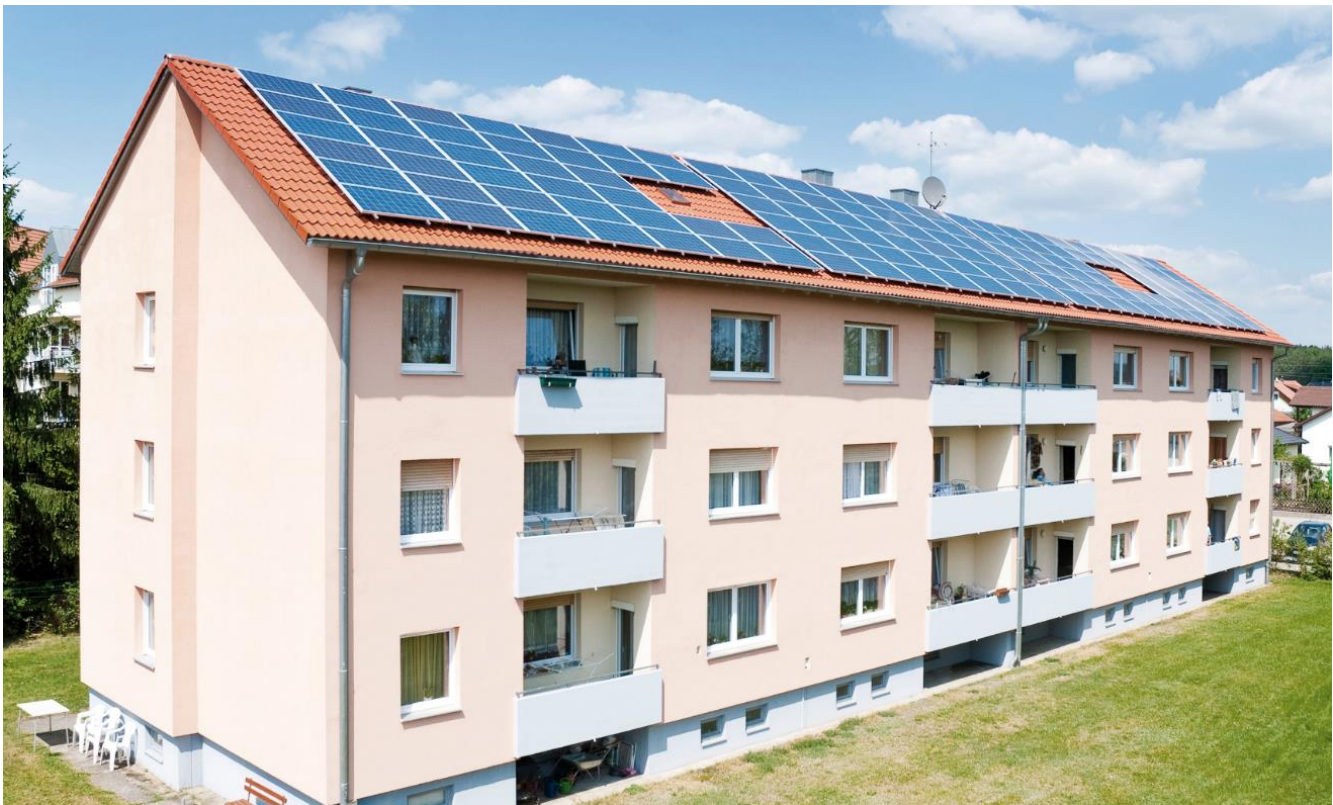
Bild: Anlage am Standort Eichenweg (2011)
